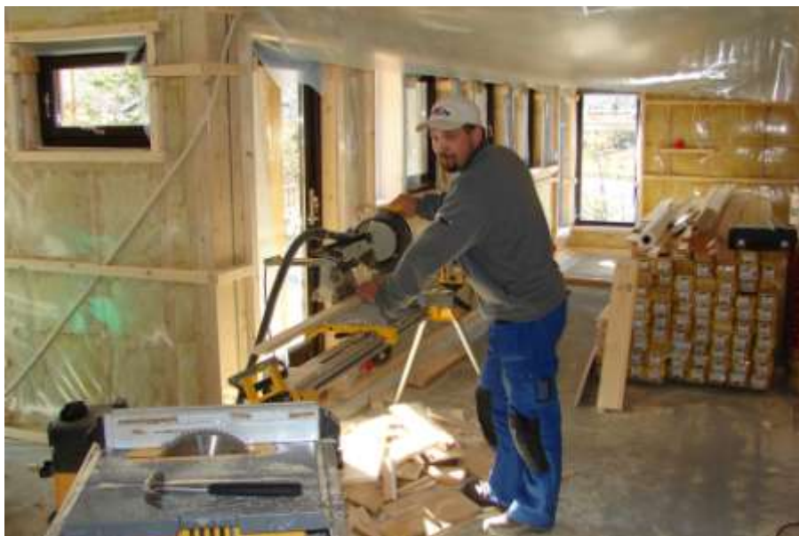
Fot. 1. Adrian Kotulak w czasie pracy na budowie.
